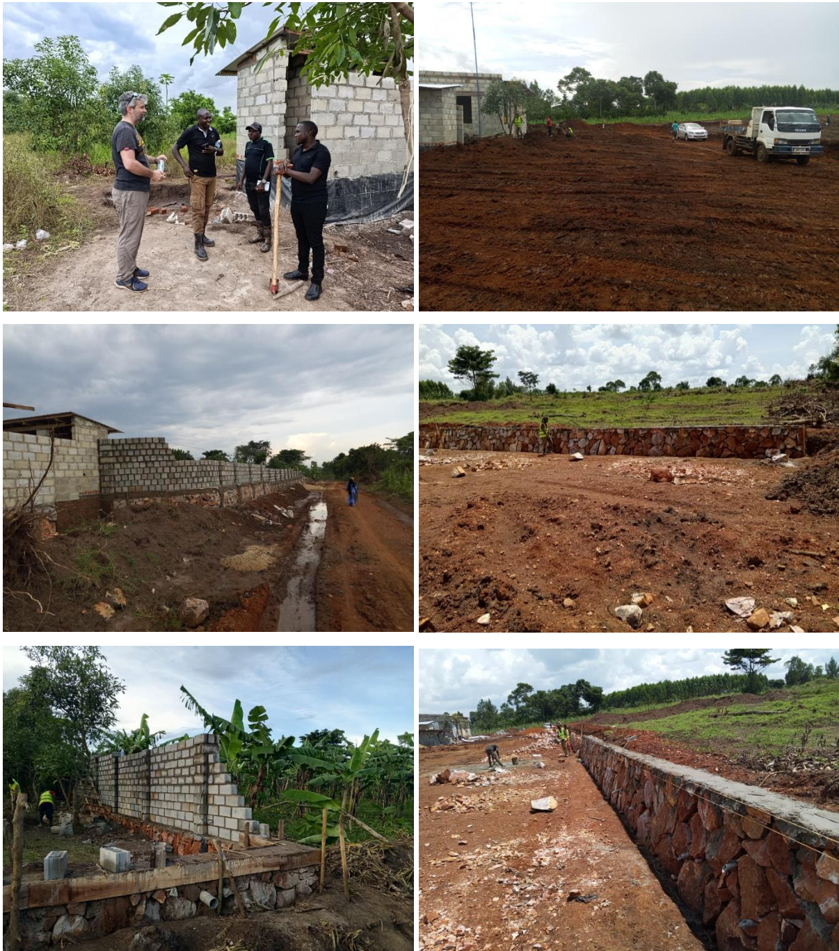
Abbildung 18: oben: Geschäftsführer Daniel Neyer bei einer Vorort-Besichtigung der Bauarbeiten auf dem neuen Betriebsgelände, April 2026.
