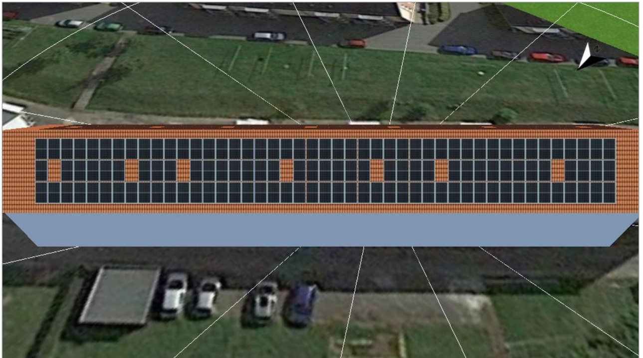
Abbildung: 2. Modulfläche - Gebäude 01-Dachfläche Nordwest
