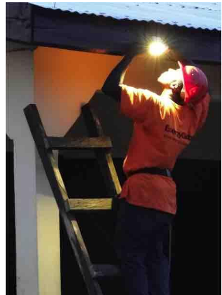
Installation eines Solarsystems
