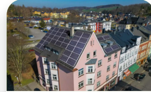
Energetische Sanierung in Rodewisch
